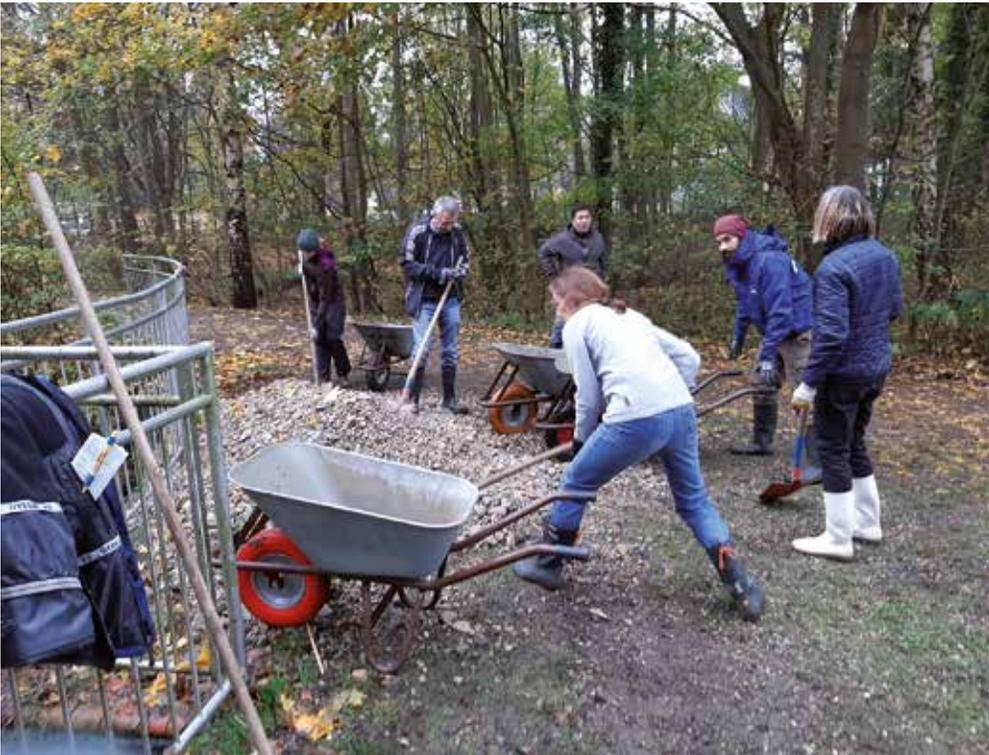
Im Bachbett mussten die Kiesmengen sinnvoll zu Kiesnasen geformt werden – strömungshemmend oder die Fließgeschwindigkeit erhöhend. Da half Jakob stark mit.
