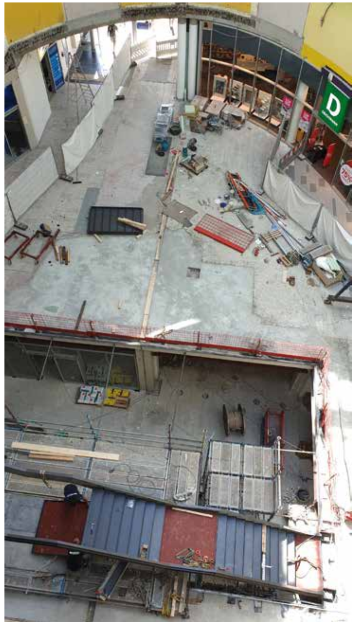
Das Bild zeigt den Blick vom 4.OG in das Erdgeschoß mit der grossen Öffnung, durch die das Untergeschoß zu sehen ist.
